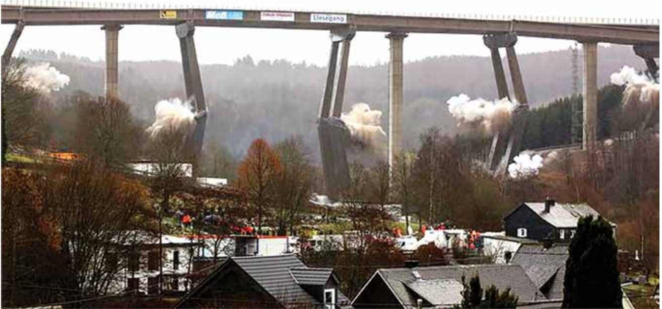
Esant įsiveržimo grėsmei, tiltai, viadukai ir tuneliai bus sprogdinami. Minima, kad Žiemos karo metu vieno tilto sunaikinimas suvėlino sovietų divizijos planus visai parai.
