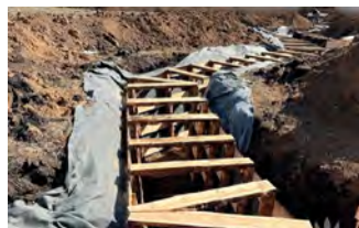
27 pav. Tranšėjų įrengimas laužytos linijos būdu – zigzagu
