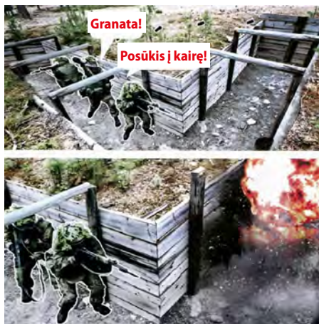
27 pav. Tranšėjų įrengimas laužytos linijos būdu – zigzagu
